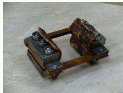
Элемент токопровода после срабатывания
