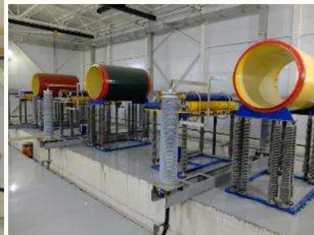
ТОУ-220 на ПС 500 кВ «Каскадная» общий вид
