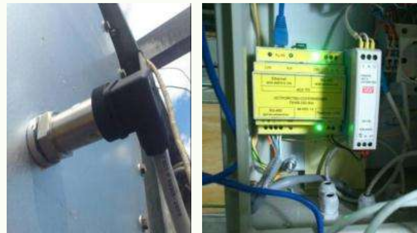
Датчик влажности и модуль сопряжения на подстанции «Каскара» АО «Тюменьэнерго»
