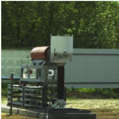
Трансформатор тока типа ТОМ-110
