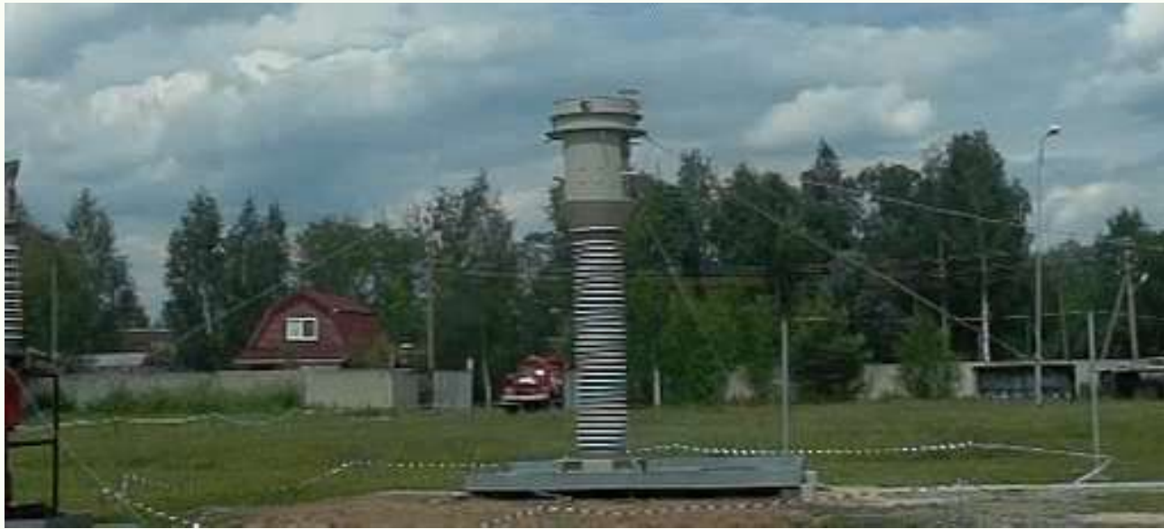
Трансформатор тока типа ТФРМ 330 кВ
