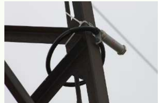
Вариант установки датчика на опоре ЛЭП
