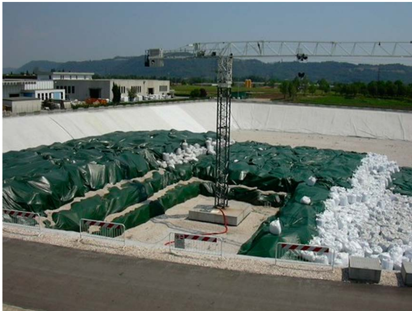
Рисунок 1.3.1 – ОСВ в биг-бэгах на полигоне для захоронения [55]
