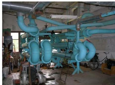
Рисунок 2.2 – Центральный тепловой пункт с кожухотрубными теплообменниками
