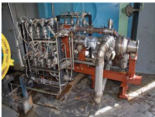
Водородно-кислородная энергоустановка 5 МВт. Время запуска: 7 сек. Удельная мощность: до 500 кВт/кг
