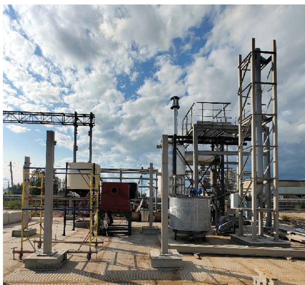
Монтаж пилотной установки на промышленной площадке ООО «ТН-Биотех» (ПГТ Актюбинский, Татарстан)
