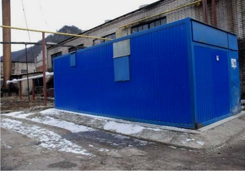
Общий вид электростанции в контейнерном исполнении
