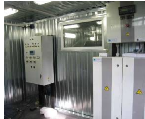
Отсек системы управления и автоматики
