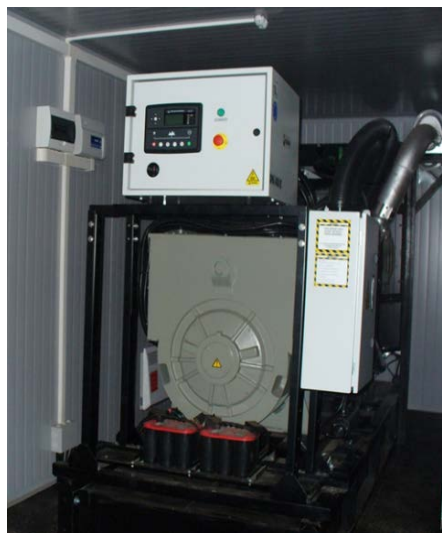
Дизельная генераторная установка Gesan DPA 400 E
